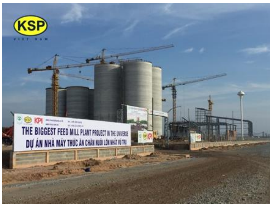
Hình 5: Dự án nhà máy thức ăn chăn nuôi Bình Phước (Feedmill Bình Phước)
